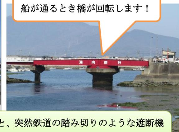
向島に橋で渡ろうとすると、突然鉄道の踏み切りのような遮断機が見えてびっくり！ 実は、橋が回転するときに使います。
